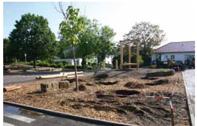
Beginn der Bauarbeiten für das Klettergerüst der Köllerholzschule © Dr. Wiltrud Geurtz, BUNDjugend NRW
